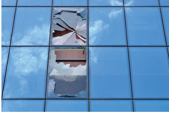
Kısmi Temperli Camın Kırılma Davranışı
